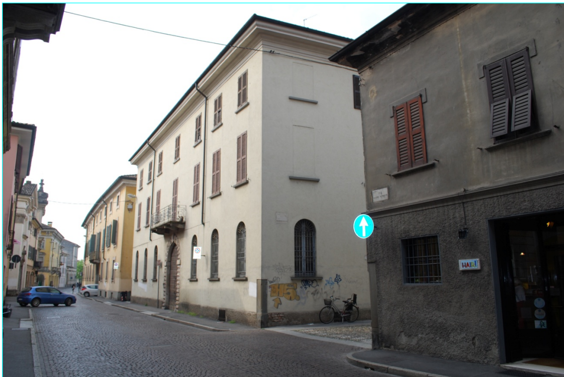
Vista da via Matteotti – foto 1
